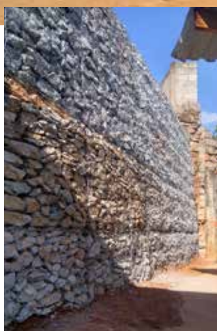
Construção do muro de contenção nas ruas Antenor Tavares e Natal Rodrigues, Jardim Marchetti
