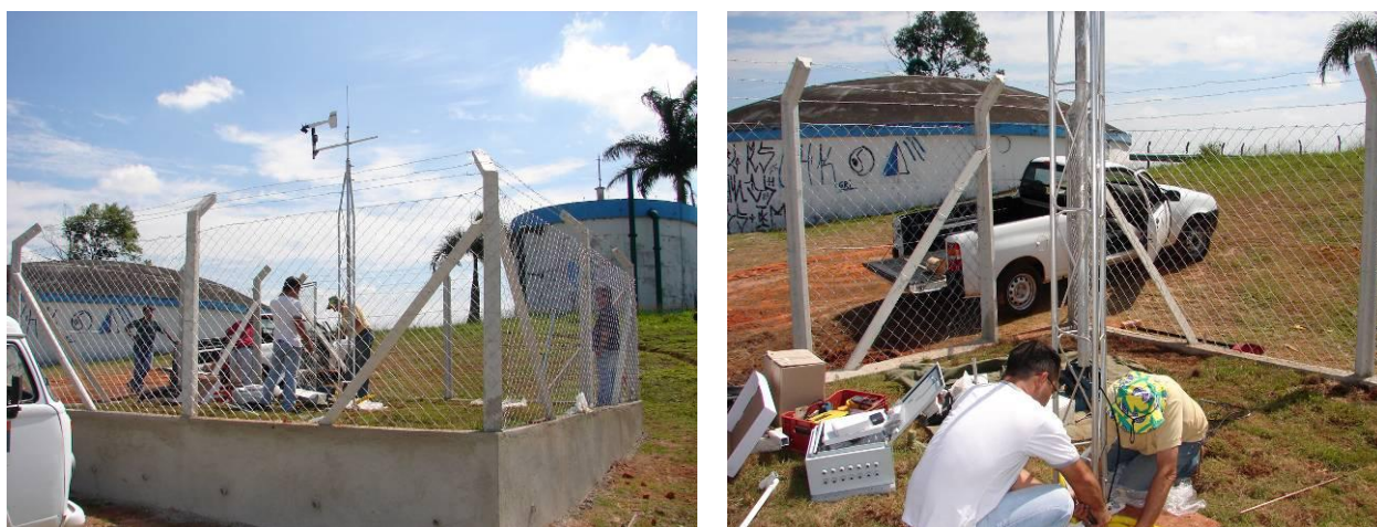
Figura 62. Instalação da estação hidrometeorológica
